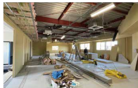
鉄骨を残し壁面を全て解体した上での改築
