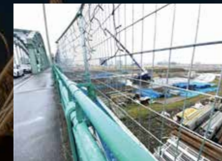
現在の中橋の様子。工事の様子がみられる。
